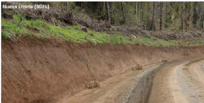
Camino interior con disipadores de energía en buen estado
